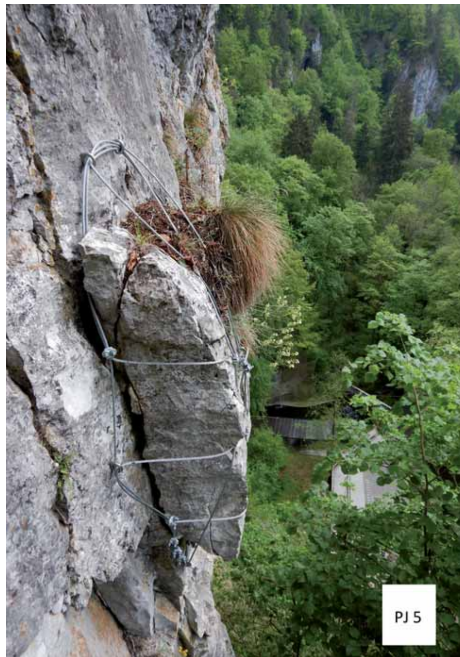
Údržba skalních stěn nad vchodem do Punkevních jeskyní. Foto SJ ČR
