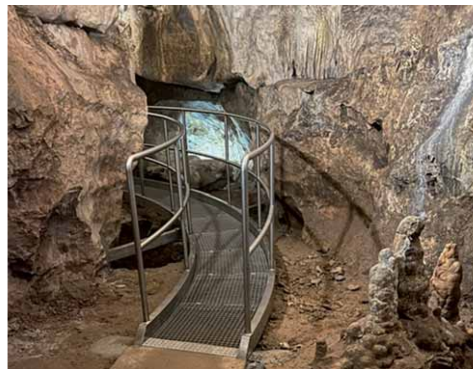
Přemostění instalované nad propadem. Foto SJ ČR
